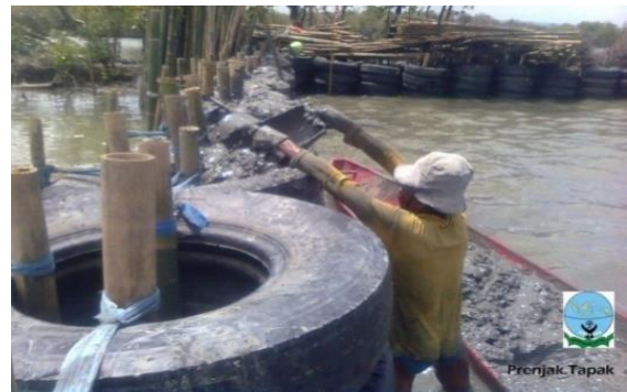
Gambar 3. Pembuatan APO dari bambu dan ban bekas di Tapak, Tugurejo, Tugu, Semarang
