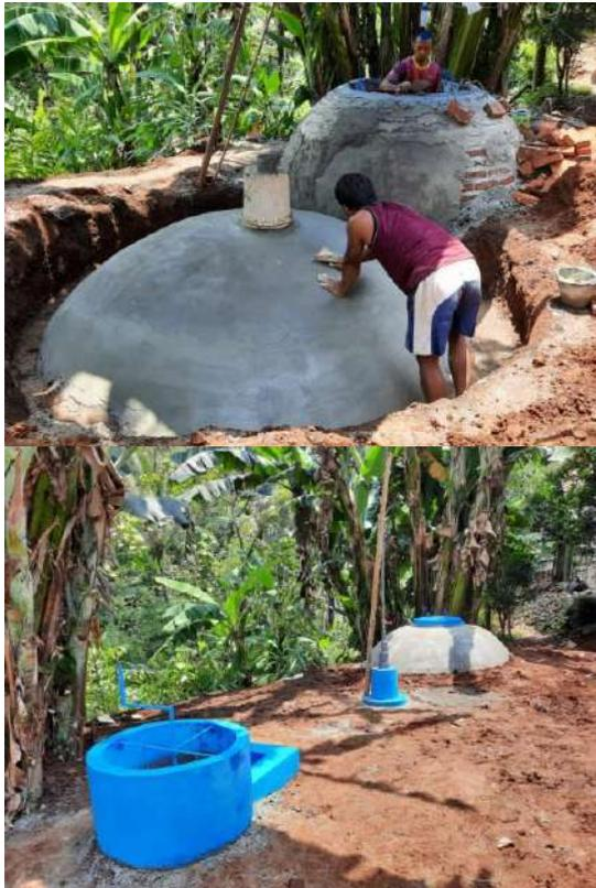
**Gambar 1.** Pembuatan digester
